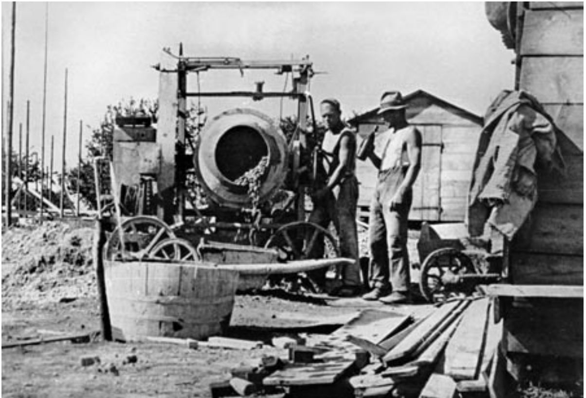
Die Baustelleneinrichtung: Als einzige Maschine stand ein Betonmischer zur Verfügung. Der fertige Beton wurde in Schubkarren eingefüllt.
